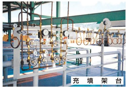
各種ガス充填設備架台
