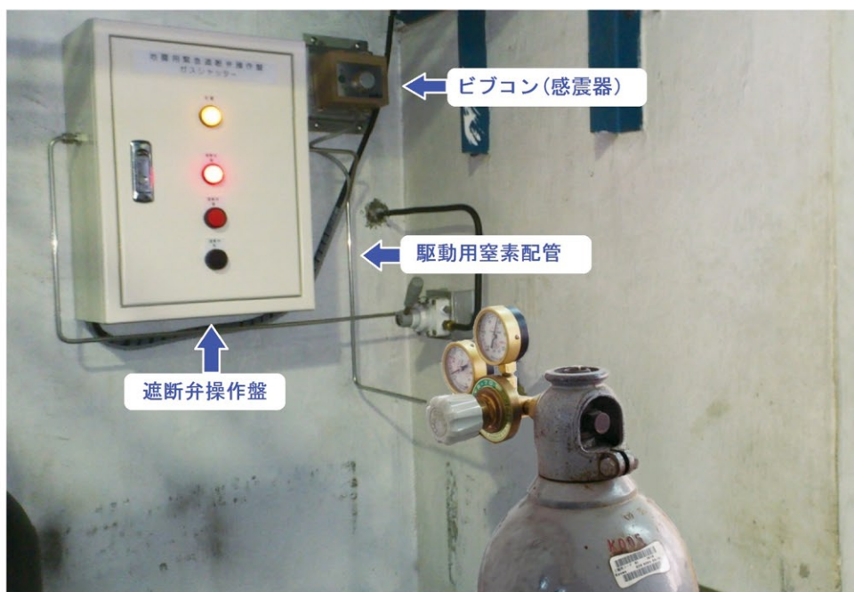
ガス充填所でのガスシャッターの設置例
